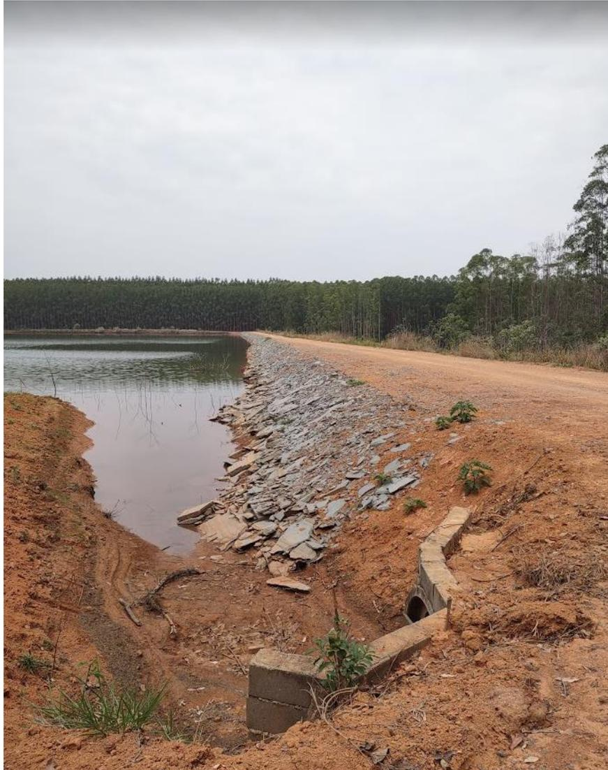
Registro fotográfico do talude de montante, a folga e a crista - No centro do talude existe a descarga de fundo. Tubulação de ferro com diâmetro de 150 mm. Por questões de segurança dos conselheiros, a estrutura de fundo não foi verificada de perto.
