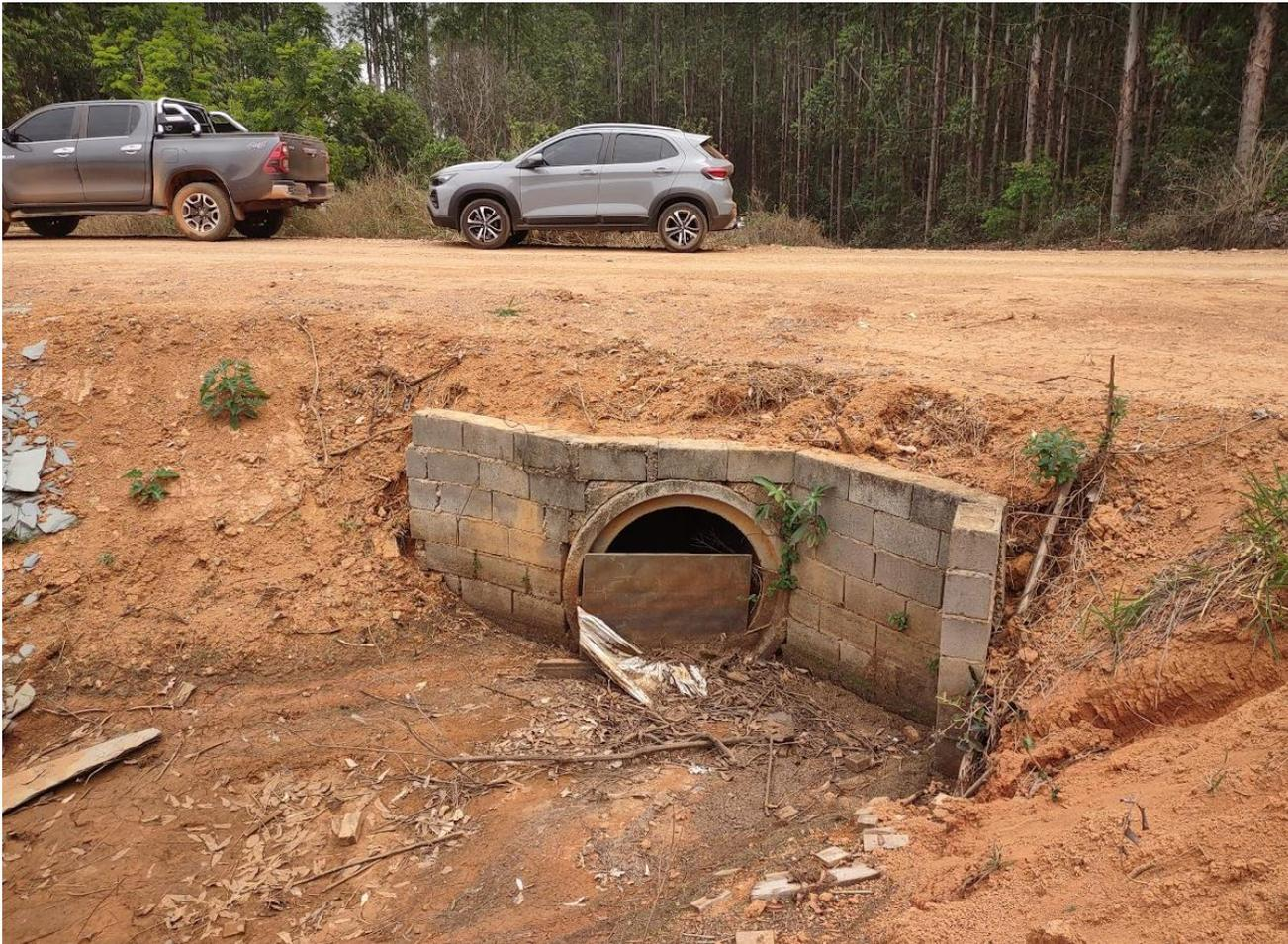
Registro fotográfico do vertedouro de emergência do barramento B3 - Durante a visita técnica foi constatado que a estrutura estava obstruída. Importante ressaltar que essa estrutura hidráulica será substituída por outro vertedouro de emergência em formato trapezoidal. Vide projeto de outorga, parecer do IGAM e anexo 2 deste relatório.
