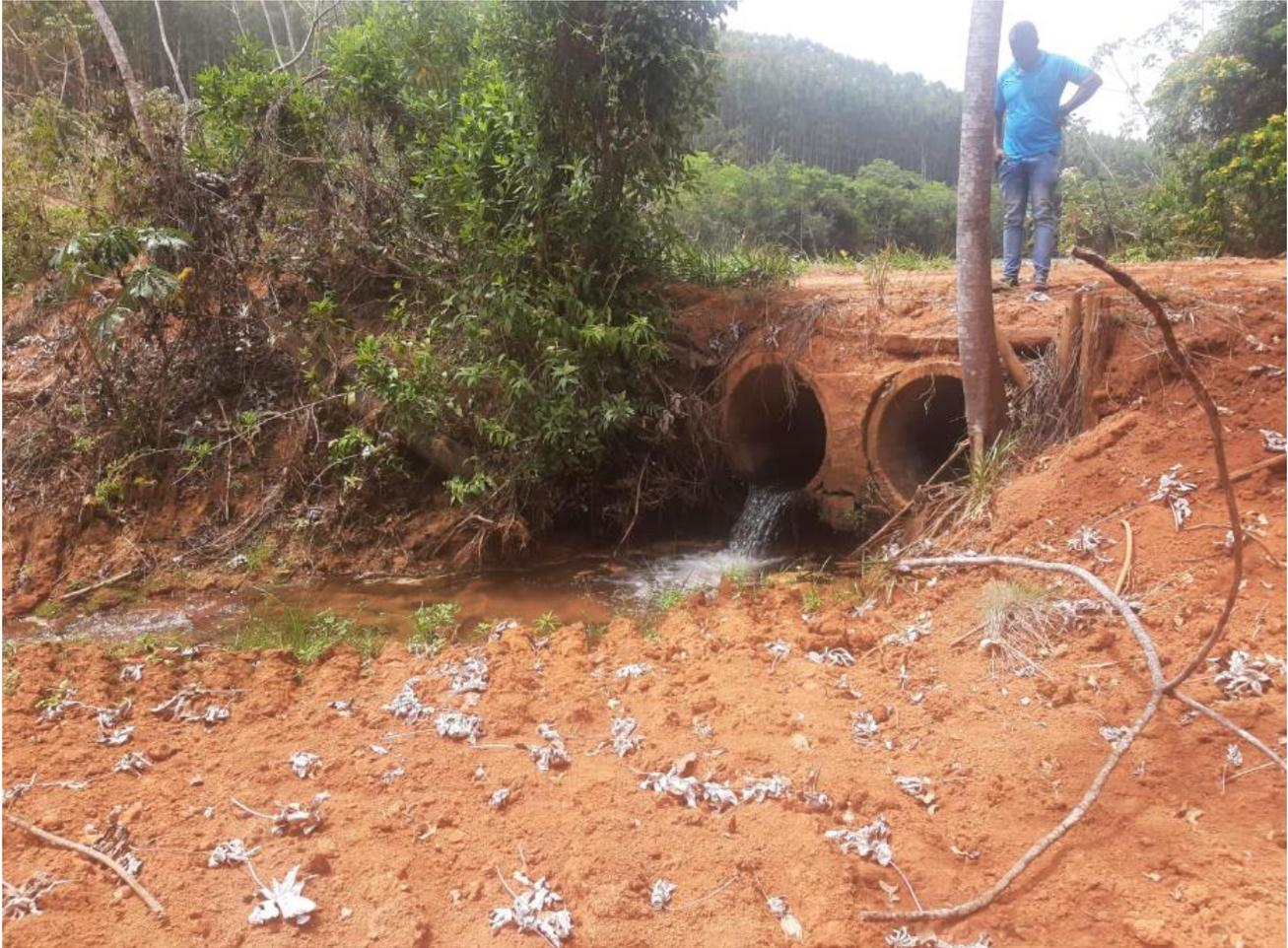
Registro fotográfico do vertedouro de emergência do barramento B4. Durante a visita técnica foi constatado que a estrutura estava em bom estado de conservação e funcionando plenamente.
