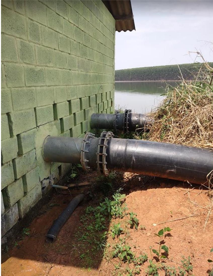
Registro fotográfico da casa de bombas em alvenaria implantada às margens do barramento B3 - Este é o padrão de todas as casas de bombas implantadas no empreendimento vista de perto. No registro é possível verificar a tubulação de sucção.
