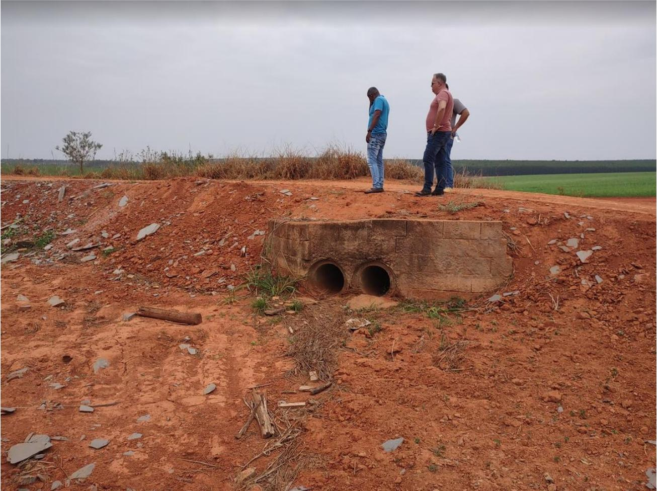
Registro fotográfico do vertedouro de emergência do barramento B1 - Durante a visita técnica foi constatado que a estrutura estava obstruída em função do carreamento e deposição de sólidos. Foi recomendado aos responsáveis técnicos a manutenção do mesmo.
