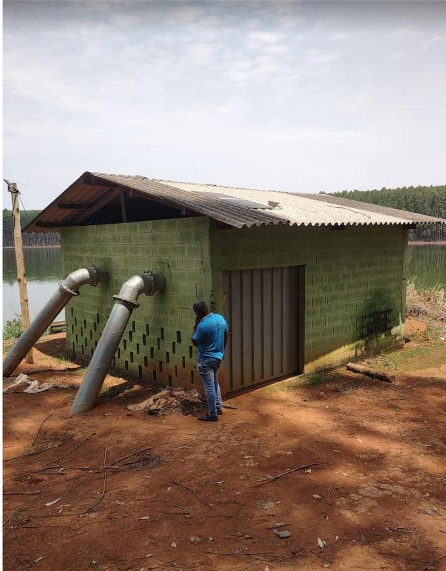
Registro fotográfico da casa de bombas em alvenaria implantada às margens do barramento B3 - Este é o padrão de todas as casas de bombas implantadas no empreendimento vista de perto. No registro é possível verificar a tubulação de recalque.
