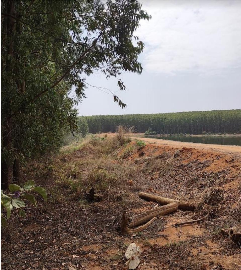
Registro fotográfico do talude de jusante do barramento B3 - Durante a visita técnica observou-se que esse talude está sendo invadido por vegetação de porte arbóreo. Os responsáveis técnicos do empreendimento foram alertados sobre a necessidade de realizar o controle contínuo da vegetação, tendo em vista que ela pode induzir processos erosivos e danos estruturais, colapsando por completo as estruturas.
