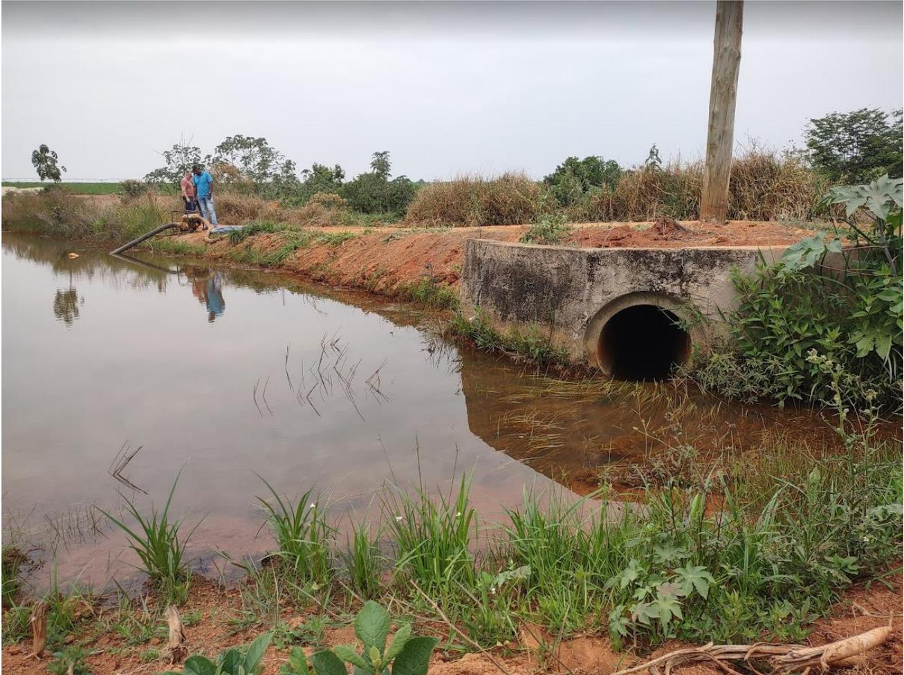
Registro fotográfico do vertedouro de emergência do barramento B2 - Durante a visita técnica foi constatado que a estrutura estava em bom estado de conservação e funcionando plenamente.
