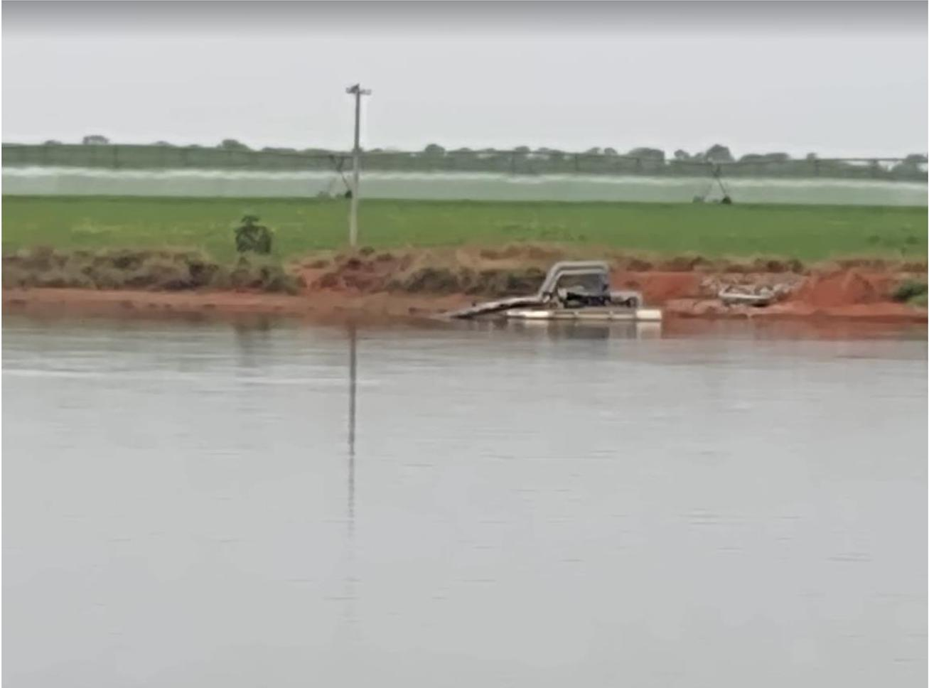
Registro fotográfico da balsa com duas motobombas instaladas. As bombas são ligadas em série com duas outras bombas instaladas em uma casa de bombas em alvenaria, localizada às margens do barramento B1.
