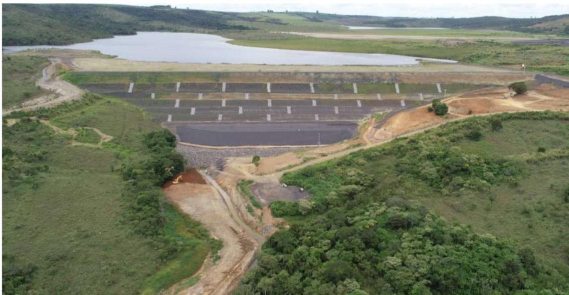
A Barragem BR, foi construída em meados da década de 80 com a finalidade de contenção de rejeitos e lamas gerados na usina através do processo de beneficiamento do minério. A água liberada dos rejeitos é bombeada e reutilizada no processo industrial e não há captação de água oriunda de vazões naturais (água nova).
